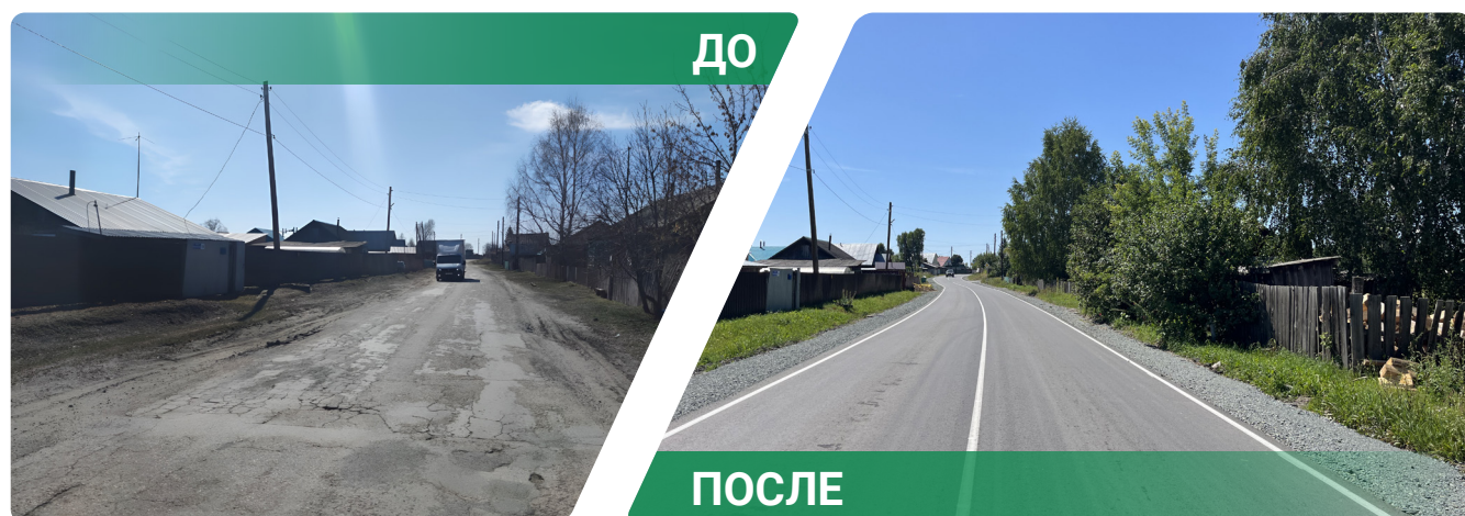
Алтайский край, подъезд к станции Озерки
