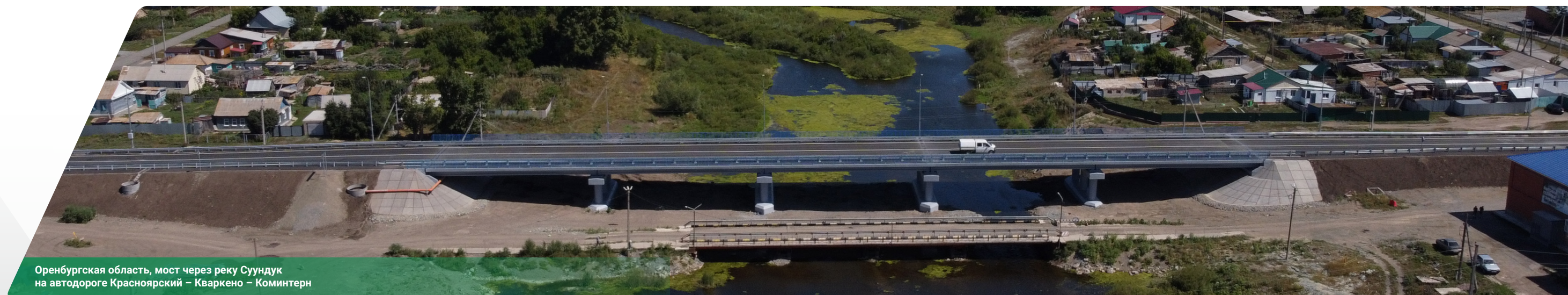
Московская область, участок Южно-Лыткаринской автодороги – от Володарского до Лыткаринского шоссе, с выходом на трассу М-5 «Урал» (9 км)
