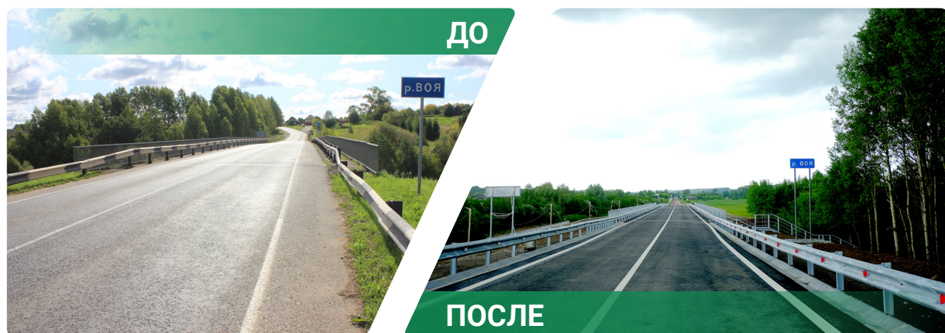
Кировская область, мост через р. Вою
